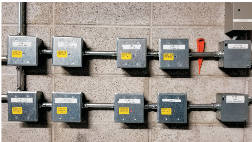
SimplexGrinnell Fire Alarm Modules
